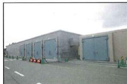
保管庫の設置
