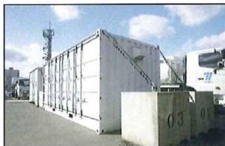
資材保管用コンテナの固縛対策
